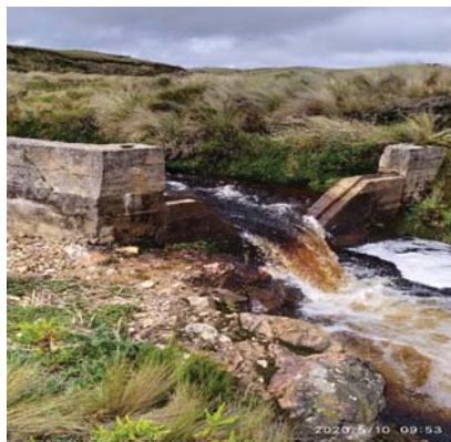
Fotografía 3. Vista panorámica del punto de monitoreo
