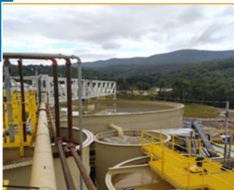
Desechos líquidos no peligrosos
