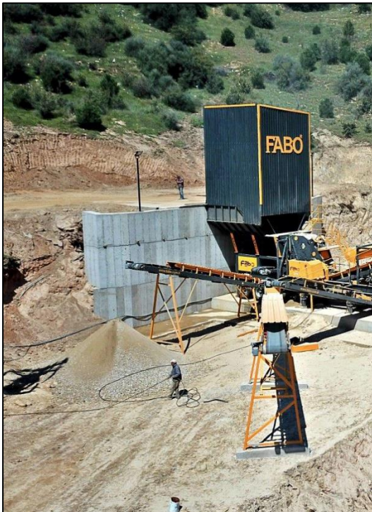
Figura 7-53 Ejemplo de un Molino de Bolas dentro de un Edificio Revestido con Lámina (vista externa)
