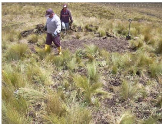
Foto 8.7. Rehabilitación de plataformas (Foto de archivo)
