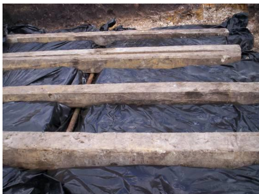
Foto 8.6. Impermeabilización de las plataformas (Foto de archivo)
