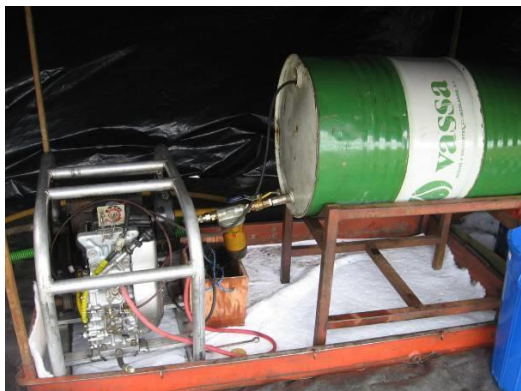
Foto 8.25. Disposición de tanques de combustible (Foto de archivo)
