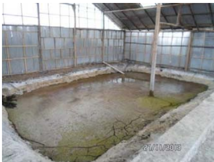
Foto 8.11. Poza de almacenamiento temporal de lodos y ripios de perforación. (Foto de archivo)
