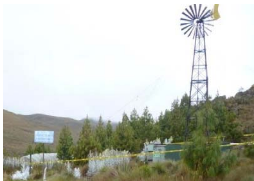
8.15. Planta de tratamiento (Campamento Pinos).
