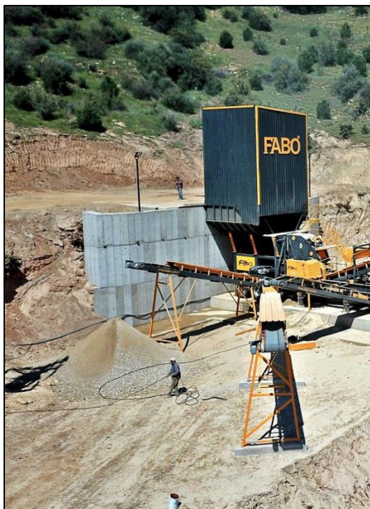
Figura 7-52 Ejemplo de un Molino de Bolas dentro de un Edificio Revestido con Lámina (vista externa)
